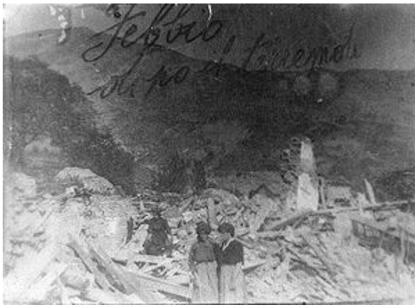
I danni del terremoto del 1920 a Febbio
